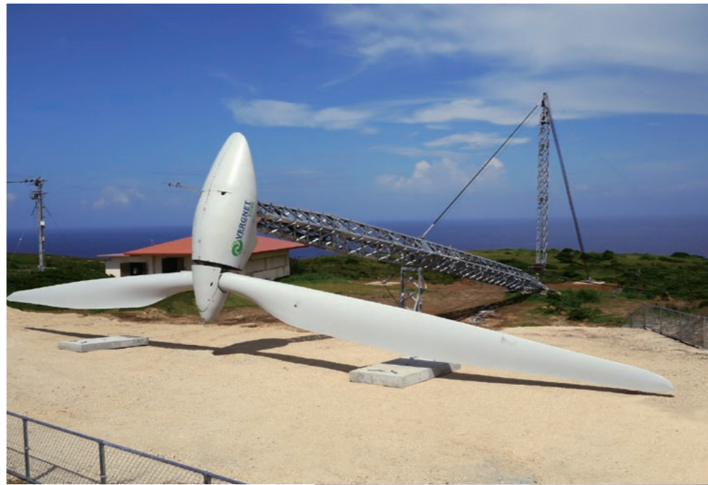
沖縄では現在5基が稼働。支柱を倒し、風車を地面に固定させて暴風から守る
