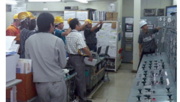
本島から約100キロ離れた久米島の発電所を見学。沖縄の離島では全てのディーゼル発電所で経済負荷配分の手法が導入されている
